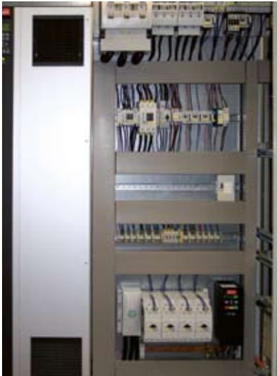
Frequenzumrichter 160 kW
